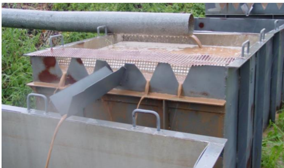
OBRÁZEK 5: FUNKCE REDUKČNÍCH NÁDRŽÍ PŘI PŘÍVALOVÉ SRÁŽCE
